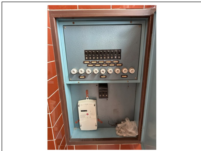
Pojistková a elektroměrná skříň.
