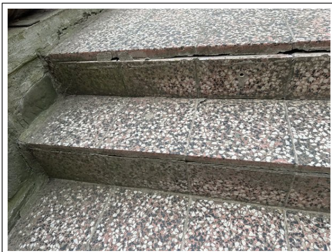
Degradace venkovních povrchů.
