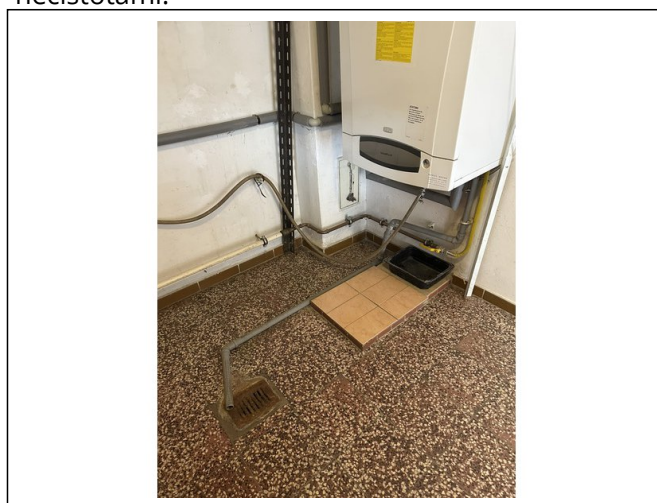
Nesystémové řešení odvodu kondenzátu od kotle.
